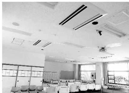
D館エアコン更新
